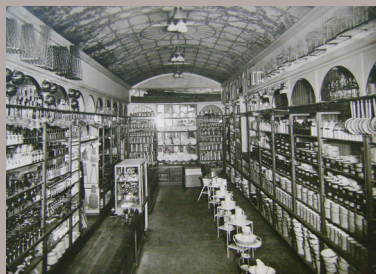
Místnost č. 9 (pohled od schodiště do čela prodejní místnosti), která se nacházela v suterénu starší, secesně upravené budovy, zakomponované do nového obchodního domu. Zdroj: Krčmář V., Krčmářová E., Rosová R.: Obchodní dům Breda. Stavebně historický průzkum, Opava 2010
